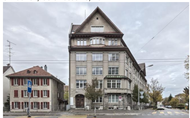
St. Gallen, Rorschacherstrasse 139, Helvetiastrasse 27
