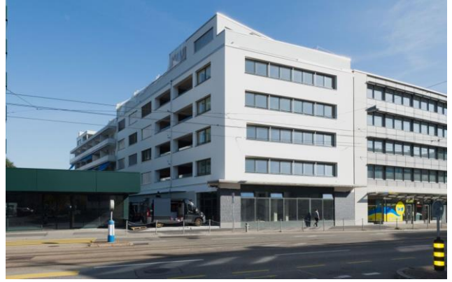
Zürich, Badenerstrasse 696, J. Fügli-Strasse 16, 18, Bachmattstrasse 53
