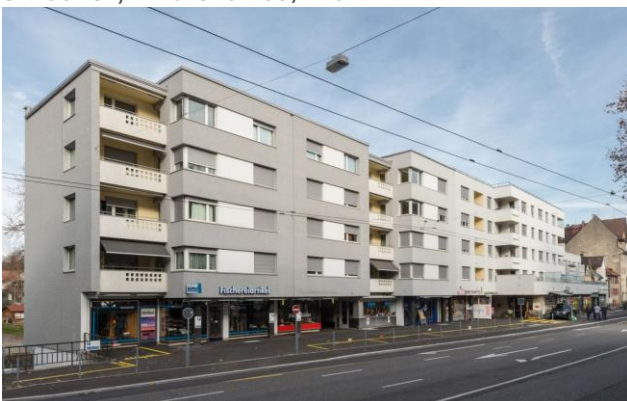
St. Gallen, Rorschacherstrasse 123, 125, 127
